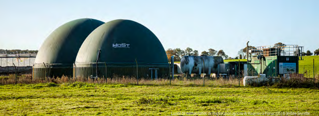
L'unité de méthanisation de l'exploration agricole Air Kourerien à Pipriac (35) © Jérôme Sevrette
